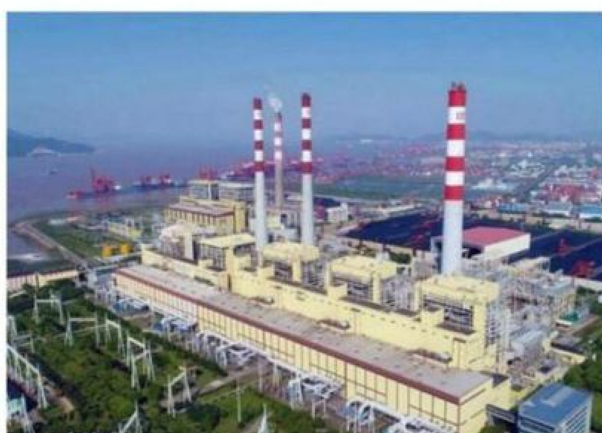
国家能源集团-浙江北仑第一发电厂
