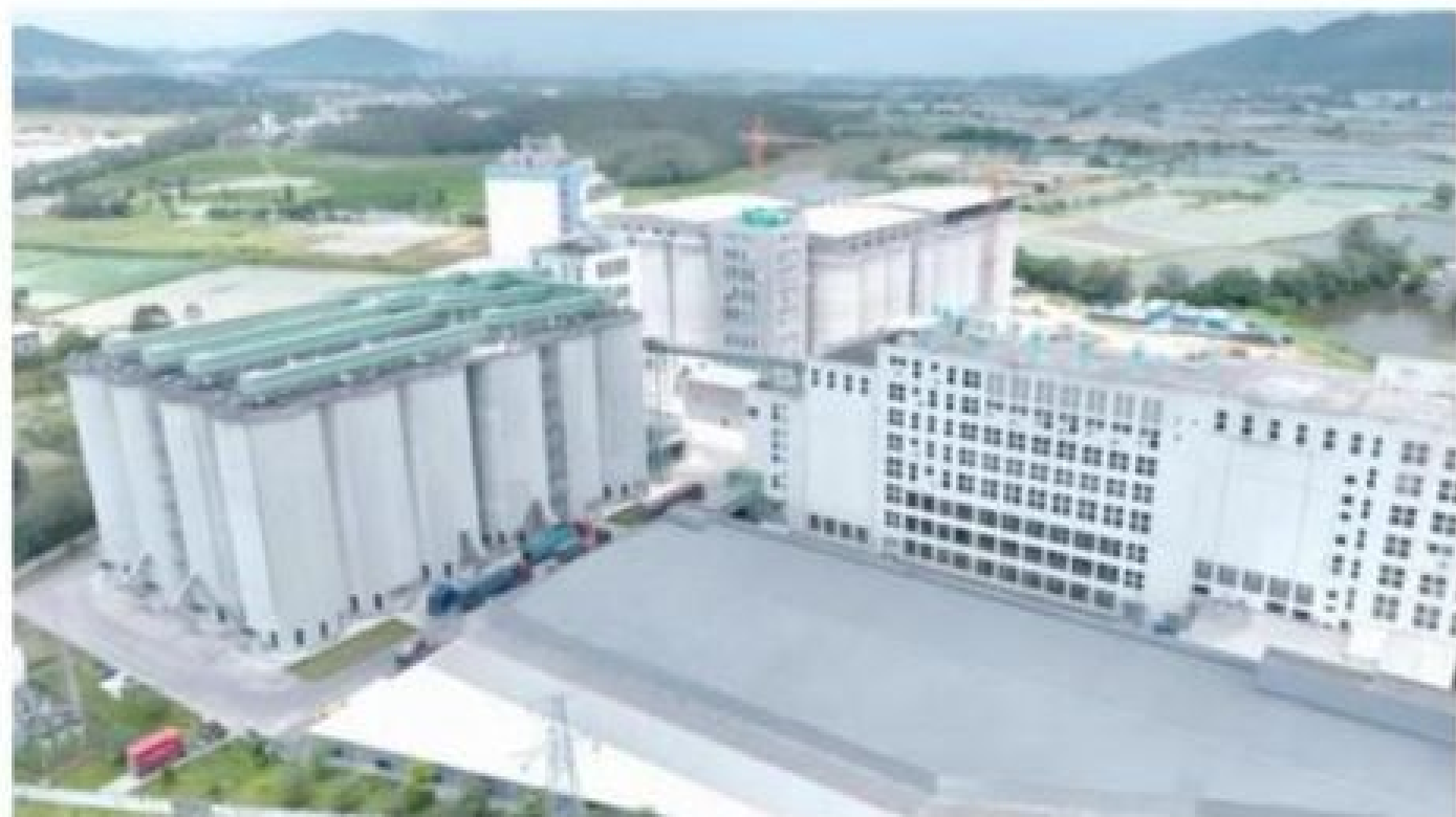
广东加福加德食品有限公司的二期仓储物流项目
